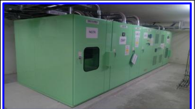
照片15 低壓配電盤
